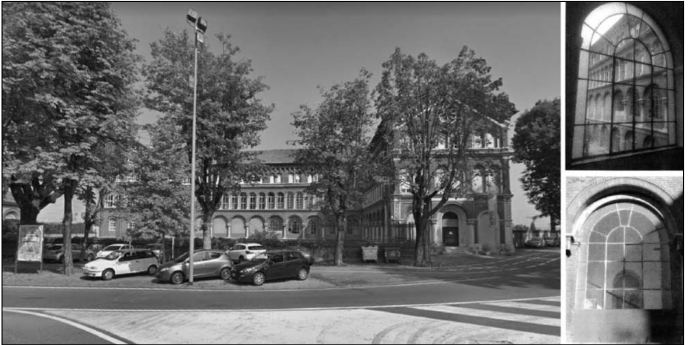
Figura 3 - Complesso San Giuseppe e dettaglio dei serramenti
