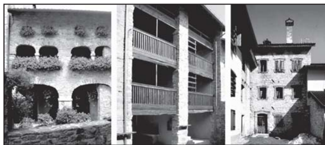
Figure 4,5 - Il tipo "a ballatoio su setti" tipico di Andreis in un edificio isolato e all'interno di una schiera (Chinellato et al., 2002).
