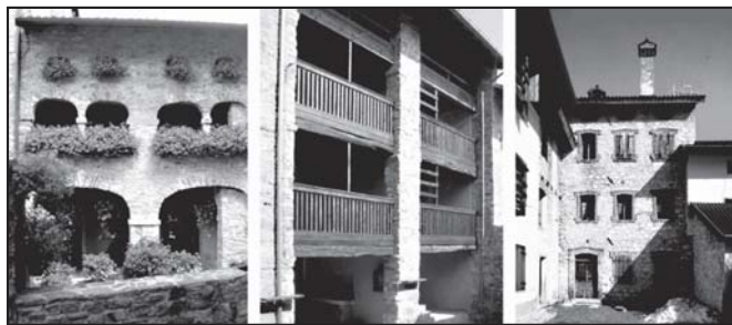
Figure 1, 2, 3 - Rispettivamente da sinistra: il tipo a portico e loggia, tipico dell'alta Valcellina, ma presente in genere nelle Prealpi Carniche e in Carnia, il tipo "a ballatoio su pilastri" in un edificio della Val Colvera e il "tipo chiuso" presente soprattutto a Cimolais e Barcis (Chinellato et al., 2002).
